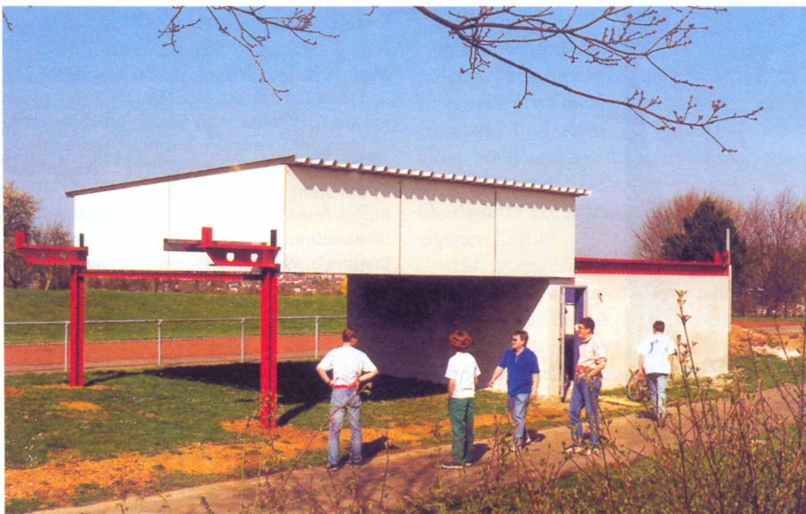
Abb. 1: Die Neckar-Alb-Sternwarte Nürtingen während der Bauarbeiten.
